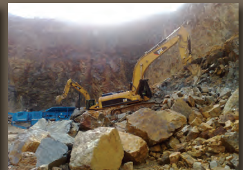
▲ Les engins en action : pelleuse, concasseur, broyeur et cribleur
