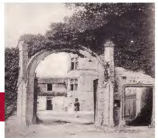
Porte XV e siècle de l'ancienne enceinte.
