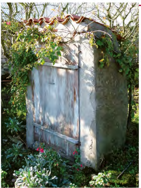
Puits à la Bossaire.
