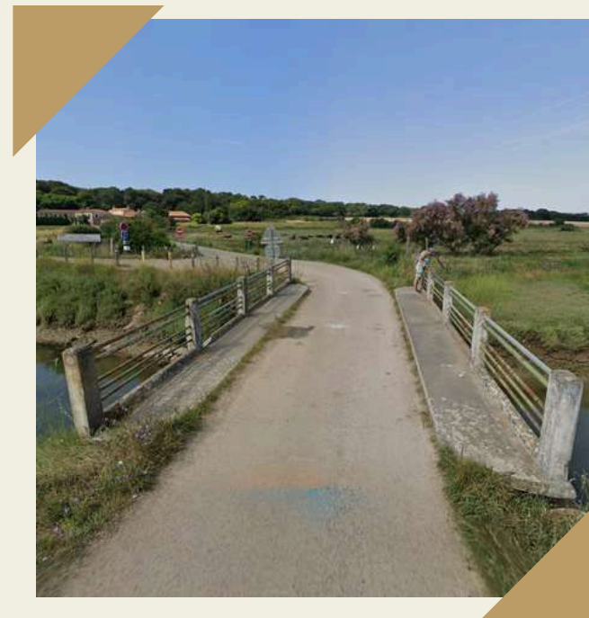
Le lancement d'un programme de réhabilitation des ponts
