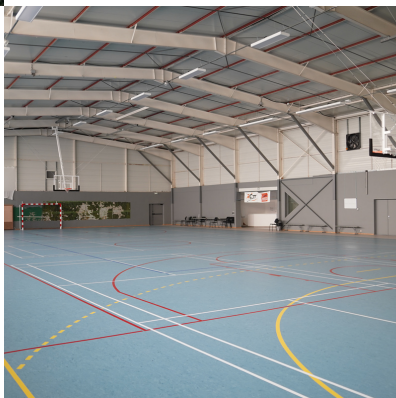
Réhabilitation SOR des Minées
