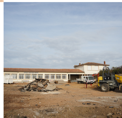
Réhabilitation école E.Charrier
