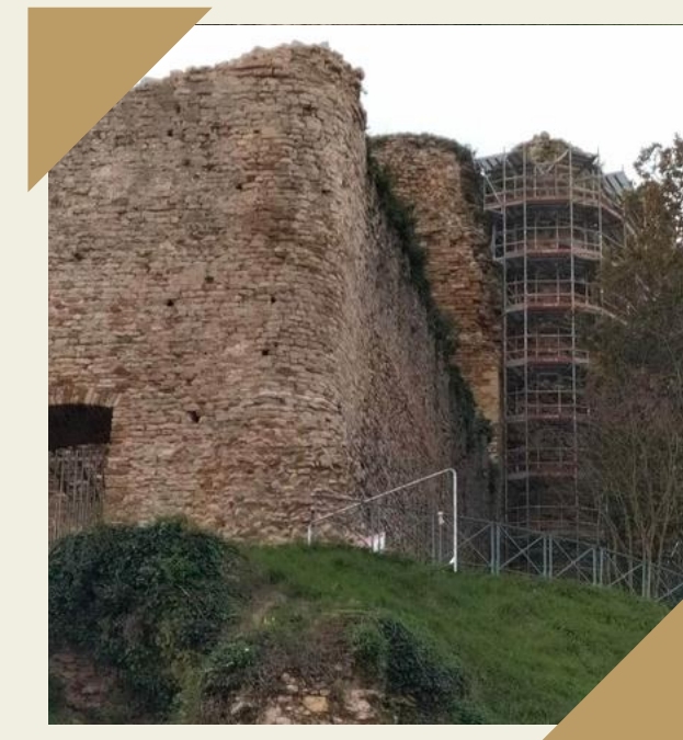
La fin de la 7ème tranche des travaux d'urgence du château
