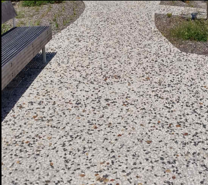
Trottoirs piéton béton désactivé
