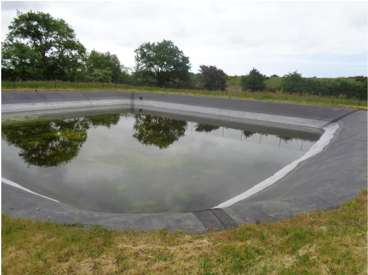
Bassin de rétention d'eau, les Ribandeaux – localisation en plan page suivante (source : Even conseil)
